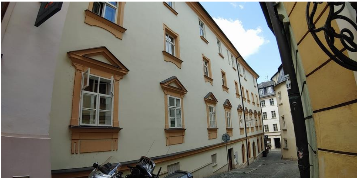
Pohled na fasádu do ulice Michalská
