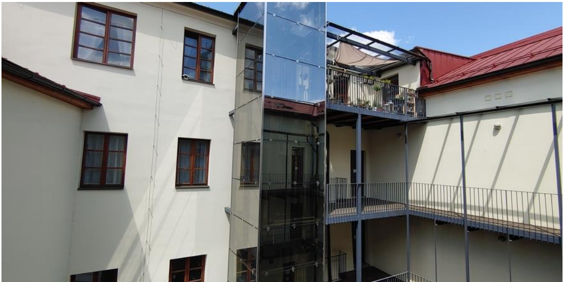
Dvorní fasáda, pohled z jihu
